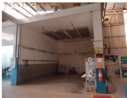
2940 - CABINE PARA LAMINAÇÃO – FABRICAÇÃO PRÓPRIA
